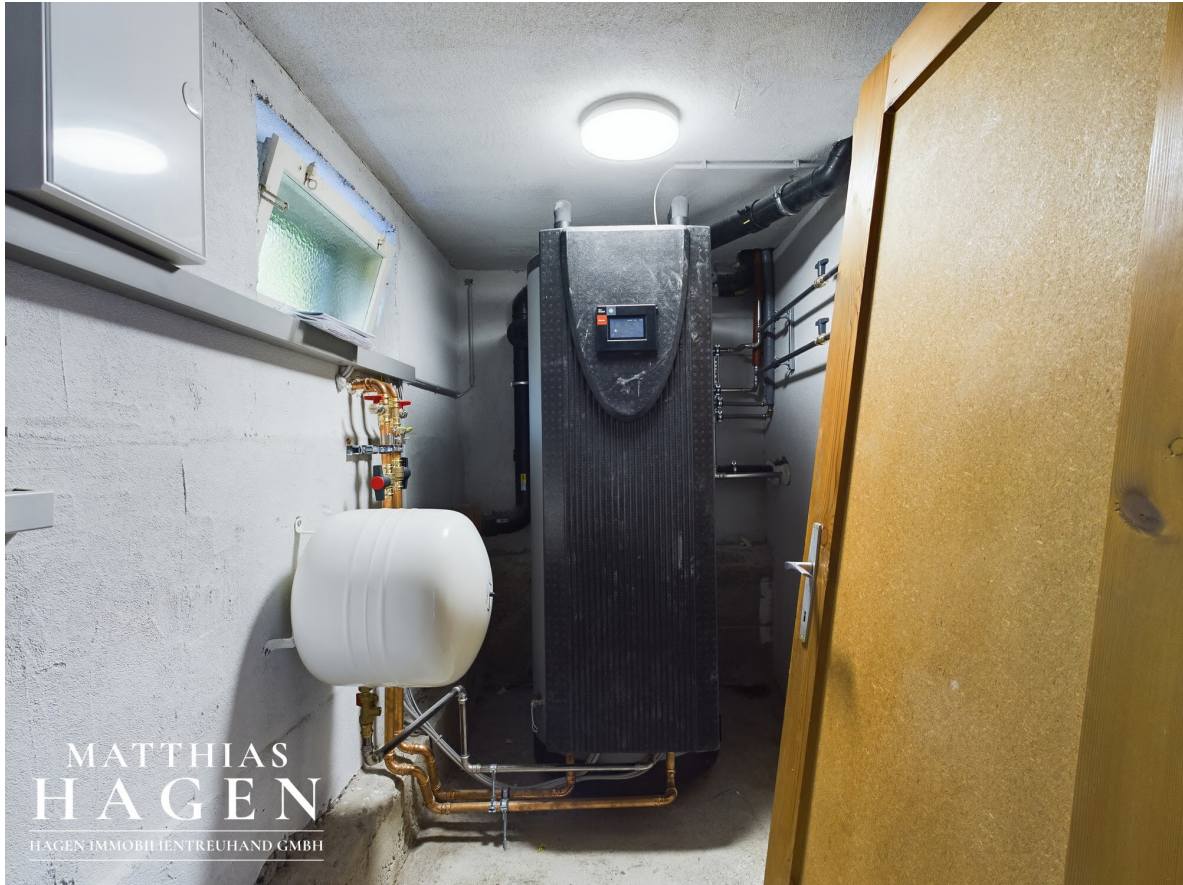
Heizraum - Luftwärmepumpe
