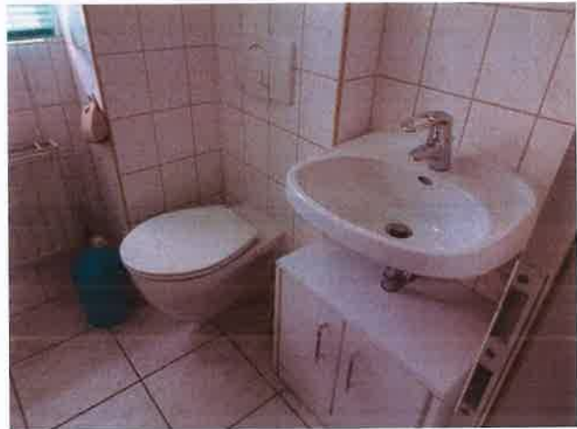
Ladeneinheit, Sanitärräume, EG
