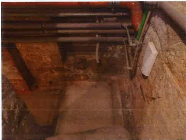
Kellertreppe mit 2 Außenwänden
