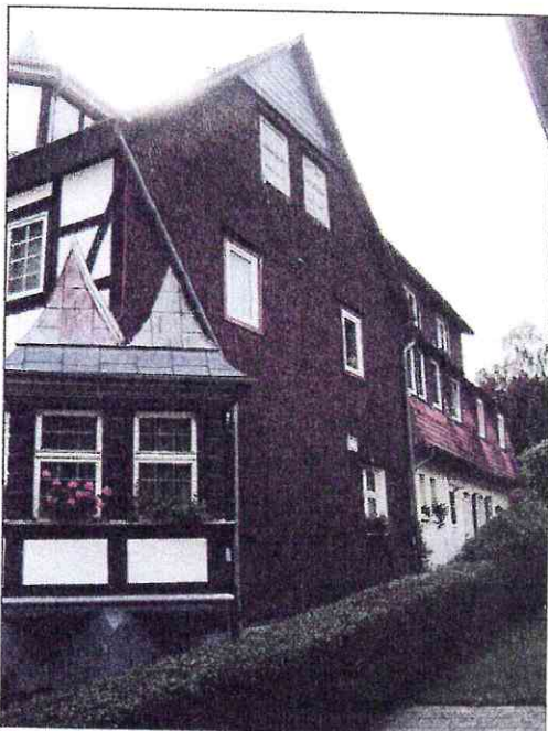
Foto Nr. 3 Westfassade / Seitenansicht
