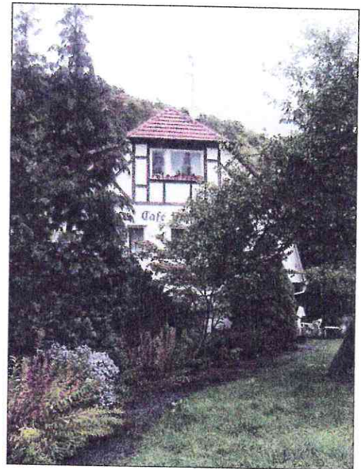
Foto Nr. 2 Südfassade / Rückansicht
