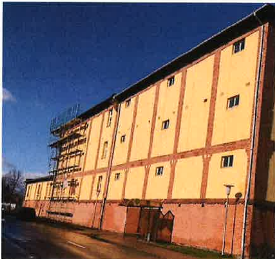
Ansicht Süden Bestand Quelle: e-con, Aufnahmedatum: 15.06.2022
