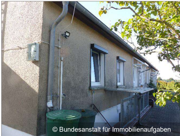
Vorderseite mit Kellerzugang
