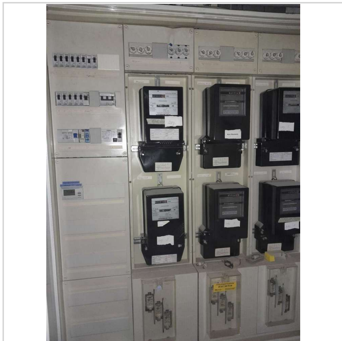
Sicherungsverteiler
