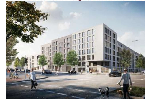
Ahrensburger Straße 95-99 und Holstenhofweg 2,2a,4,6_Hamburg
