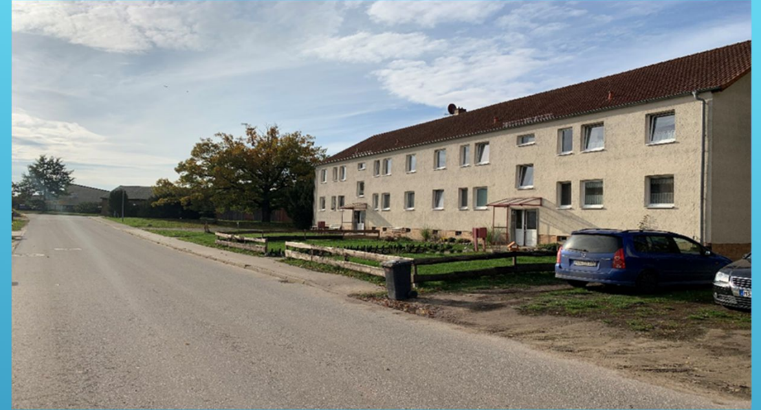
Haus-Nr. 3-5 vor der Sanierung
