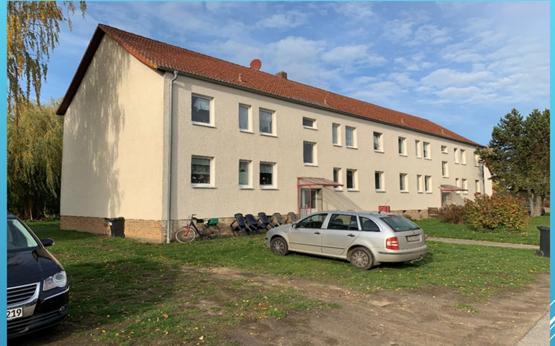
Haus-Nr. 7-9 vor der Sanierung
