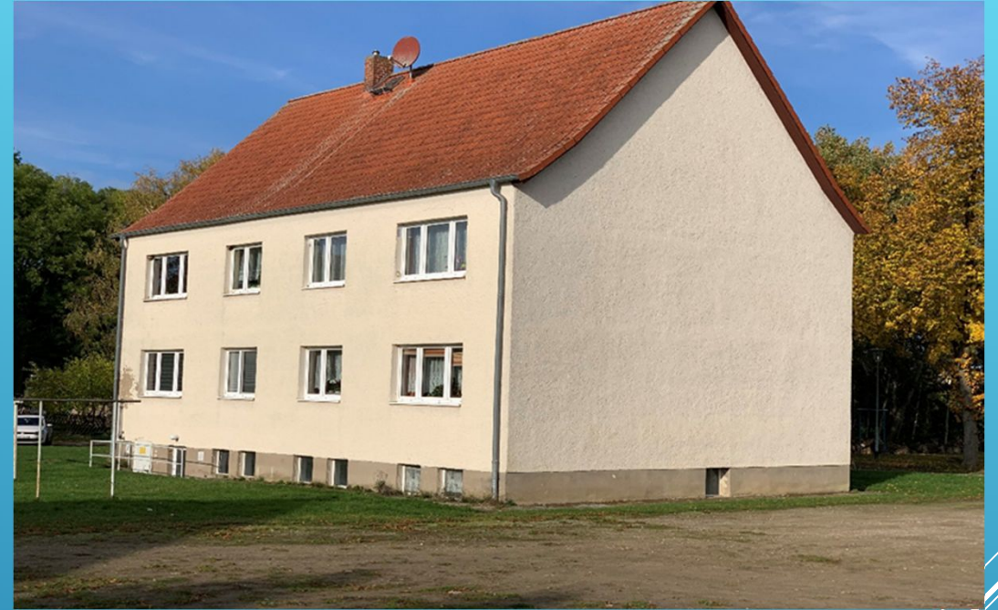
Haus-Nr. 11 vor der Sanierung
