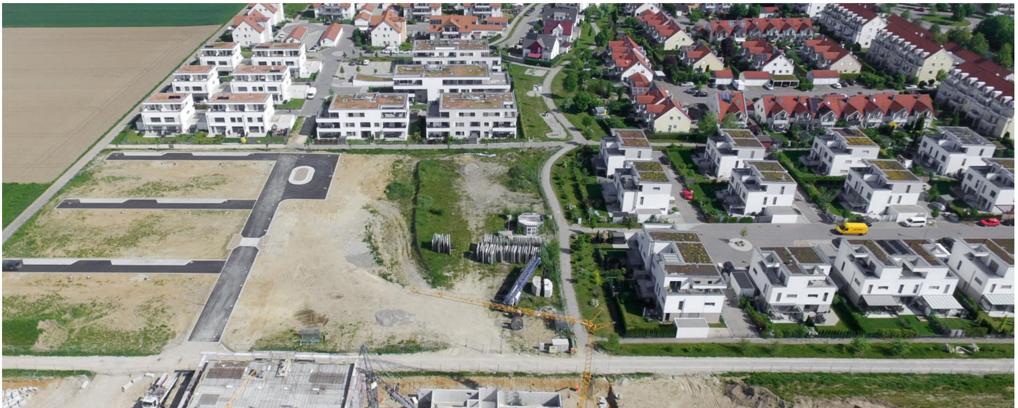
Das Baugebiet Langweid Village aus der Vogelperspektive (Bautenstand Mai 2024)
