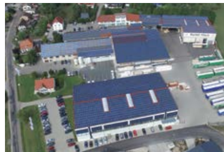
Eine der größten Fotovoltaik-Anlagen der Region produziert so viel Elektrizität, dass das gesamte Unternehmen versorgt und sogar noch Strom in das öffentliche Netz eingespeist werden kann.
