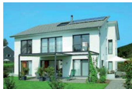
Große Glasflächen lassen die Sonne rein und versorgen das Innere des Hauses mit viel Licht und solarer Wärme. Vor zu viel Sonne schützt eine Pergola.
