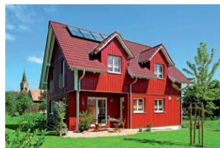
Sonne bringt Wärme: durch Solaranlagen und Holzpellets, die ja auch nichts anderes sind als umgewandelte Sonnenenergie.
