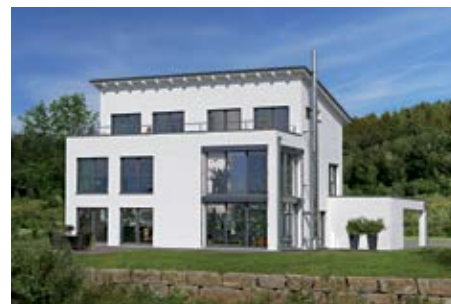
Kompakter Baukörper: nach Süden ausgerichtet, Nordseite weitestgehend geschlossen. Architektur, die einen wichtigen Beitrag zur Heizkosteneinsparung leistet.
