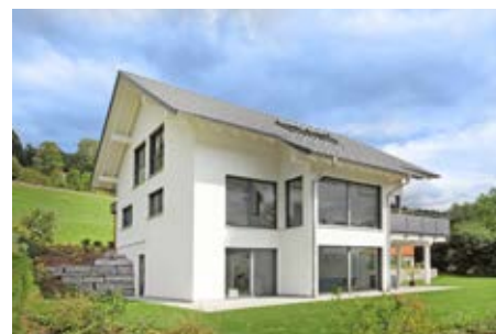
Das weit auskragende Dach schützt vor Wind und Unwetter, sommers vor praller Sonne und winters vor Kälte und Schnee.
