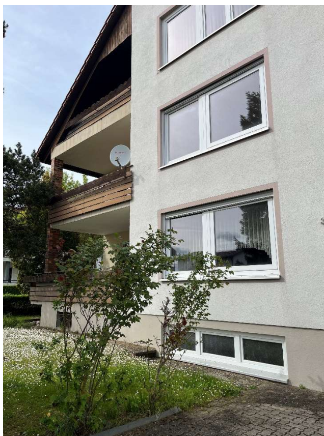
Ansicht: Einfahrt Richtung Balkon (Stellplätze) (Alt)
