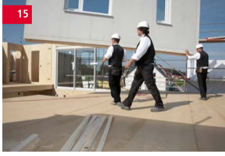
14:00 Uhr | Eine Badezimmerwand kommt angeschwebt.
