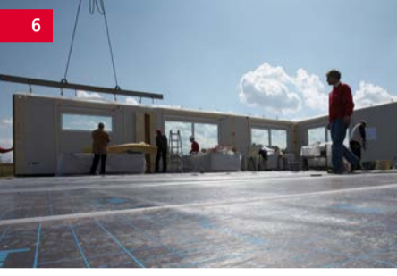
8:10 Uhr | Eine gute Stunde nach Baubeginn nimmt das Erdgeschoss Gestalt an.
