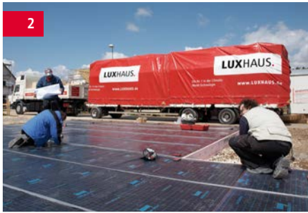
7:05 Uhr | Die ersten vorgefertigten Bauelemente werden angefahren.
