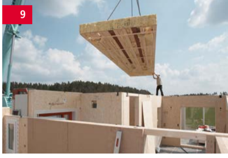
11:00 Uhr | Fertigmachen zur Landung! Die Geschossdecke schwebt ein.
