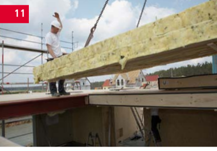
12:20 Uhr | Ruhig und zielstrebig: ausrichten, einsetzen, verschrauben.
