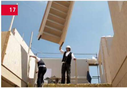
15:00 Uhr | Die Treppe kommt. Jetzt heißt es vorbereiten aufs Richtfest.
