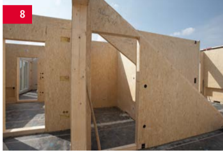
10:00 Uhr | Passt auf Anhieb. Jetzt zahlt sich die exakte Vorfertigung aus.
