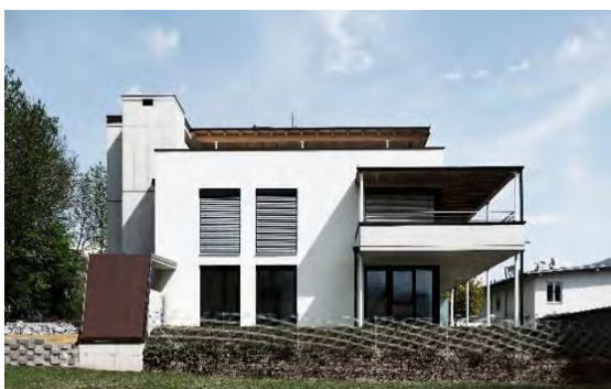
Wohnanlage Dörfer Straße, Absam
