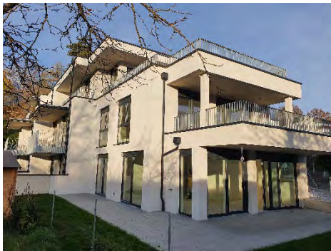
Wohnanlage Reimmichstraße 13, Hall
