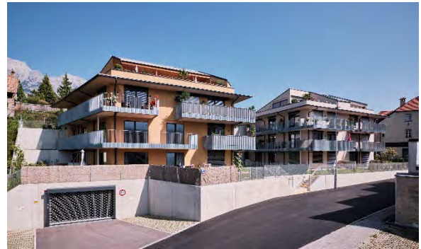
Wohnanlage Reimmichstraße 2, Hall
