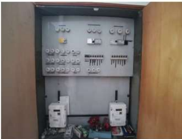
Sicherungskasten
