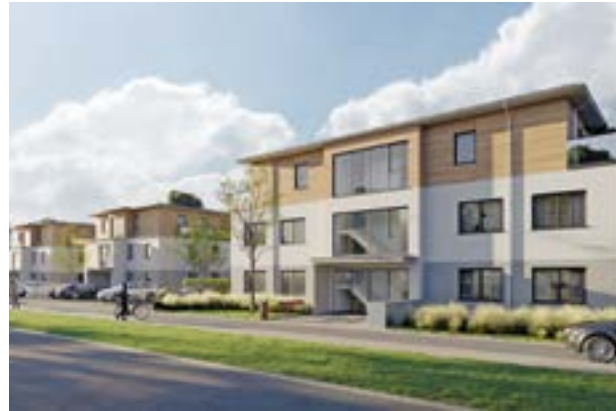
3 Mehrfamilienhäuser | 8 Doppelhaushälften | Ruderatshofen
