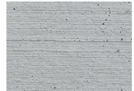
BETONPLATTE MIT BESENSTRICH
