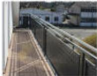
Stahlgeländer mit Ober- und Untergurt, Konstruktion nach Wahl des Bauträgers, feuerverzinkt, kein Anstrich.
