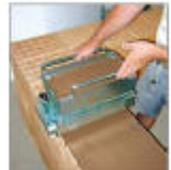
Außenwände der Geschosse ca. 17,5 cm stark mit Kalksandsteine bzw. Plansteine, geklebt.
