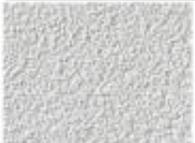
Die Außenwände erhalten einen wasserabweisenden Kratzputz bzw. Scheibenputz, Farbe und Körnung nach Wahl des Bauträgers. Sockel aus Kalkzementputz mit Anstrich, nach Wahl des Bauträgers, farblich abgesetzt.
