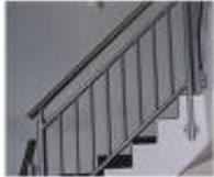
Stahlgeländer mit Ober- und Untergurt, sowie senkrechten Füllstäben, grundiert und gestrichen. Handlauf nach Wahl des Bauträgers.
