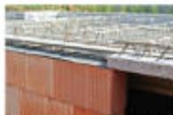
Geschossdecken in Stahlbeton, ca. 20 cm stark (bzw. nach statischer Berechnung), mit Sichtbetonunterseiten (Filigrandeckenplatten), Stöße gespachtelt.
