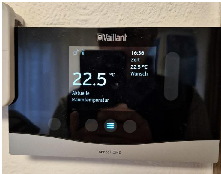
Zentralheizung mit digitale Heizungssteuerung
