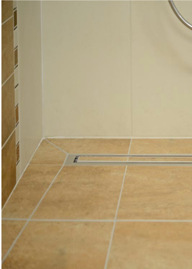
Abb. 13 Beispiel für bodengleiche Ausführung Dusche mit Entwässerungsrinne
