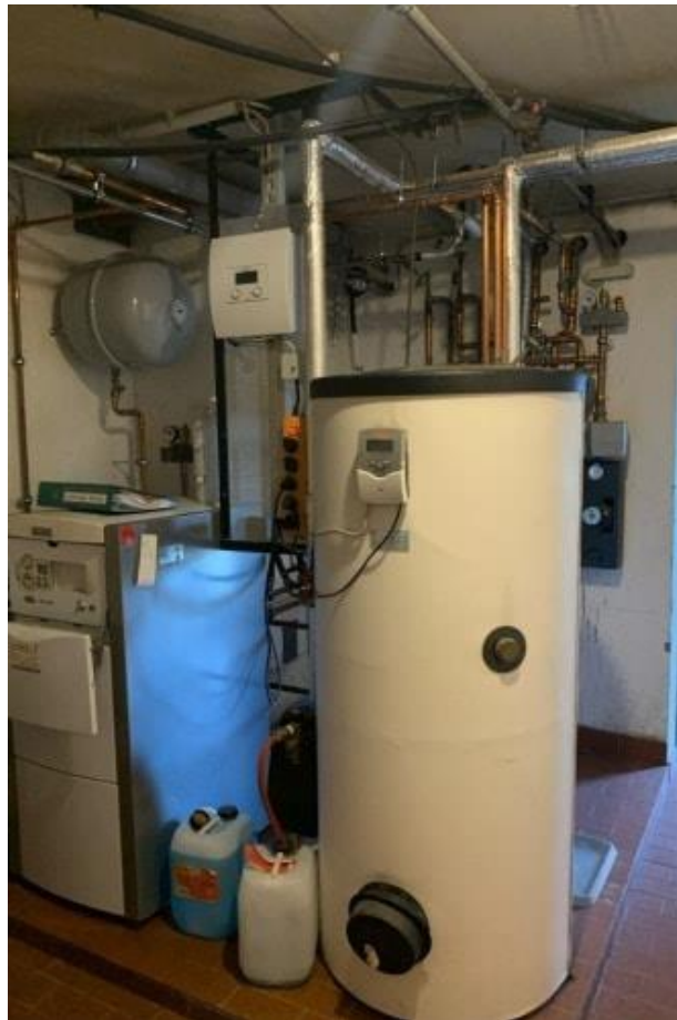
Heizanlage (ÖL) aus dem Jahr 2009 inkl. Solarunterstützung für Warmwasseraufbereitung
