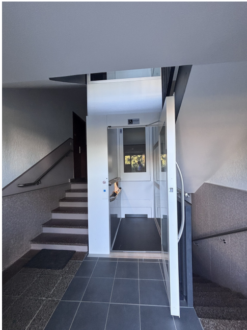
Treppenhaus mit Lift
