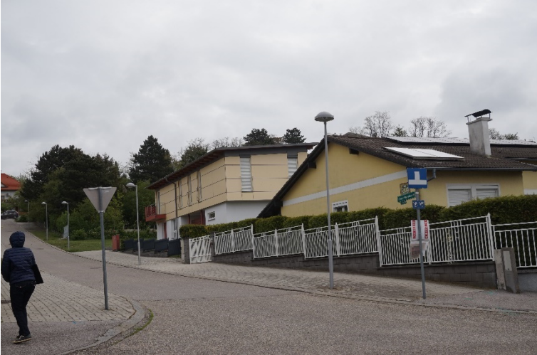
Bebauung Sauerbrunnweg/Oberer Sauerbrunn, Blickrichtung Osten
