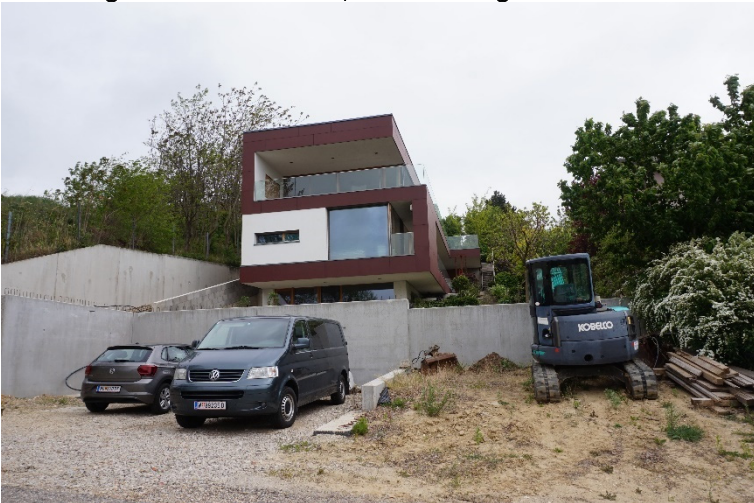
Bebauung Oberer Sauerbrunn, Blickrichtung Osten
