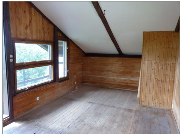
Abbildung 12: Ansicht Aufenthaltsraum Obergeschoss
