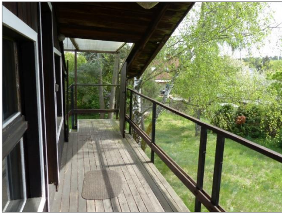
Abbildung 9: Ansicht Balkon Obergeschoss
