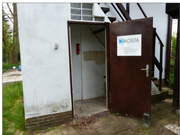
Abbildung 8: Ansicht Abstellraum unter Außentreppe
