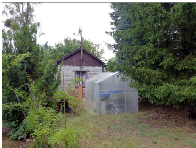
Abbildung 5: Nebengebäude (im Eigentum des Pächters)
