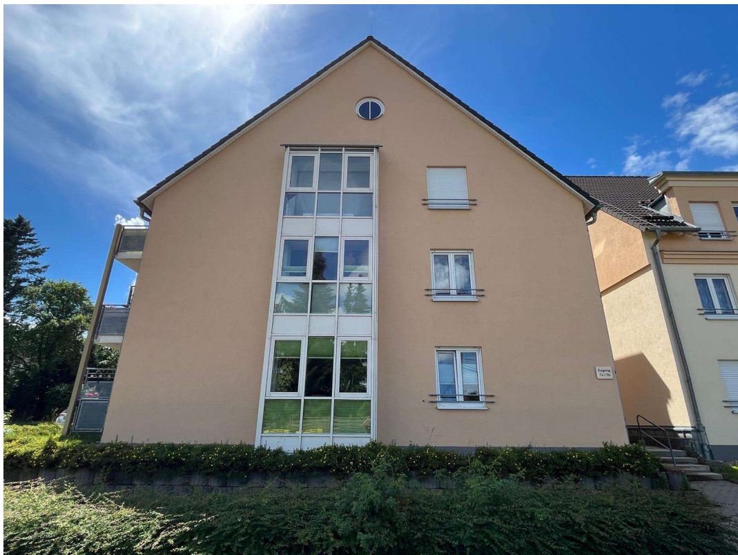
Straße der Einheit 7b - Fassadenansicht
