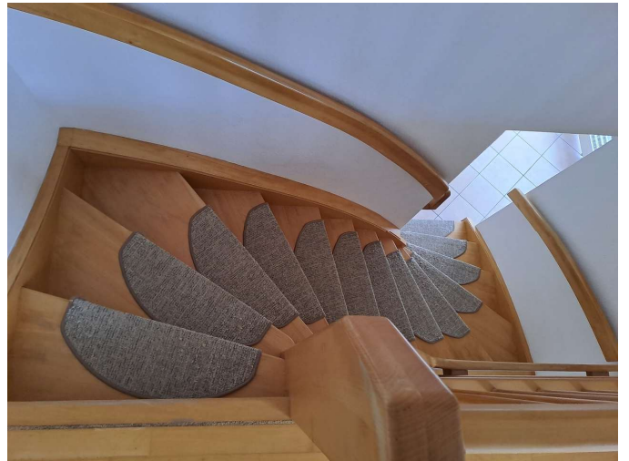
Treppe zum Erdgeschoss
