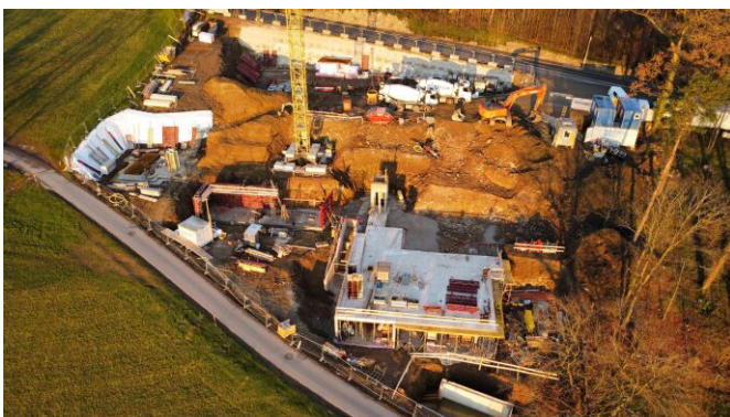
Baufortschritt vom Dezember 2024
