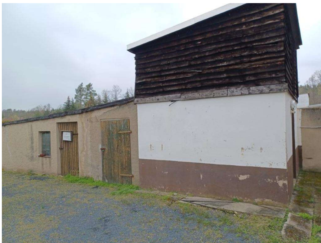
Nebengebäude mit Schuppenanbau
