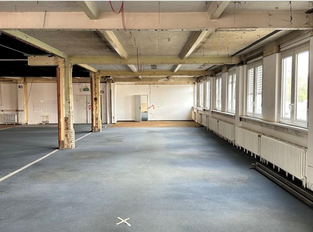
Sicht von Süden, 1. Obergeschoss, Geschossbau, Gebäude 1 (Bestand)
