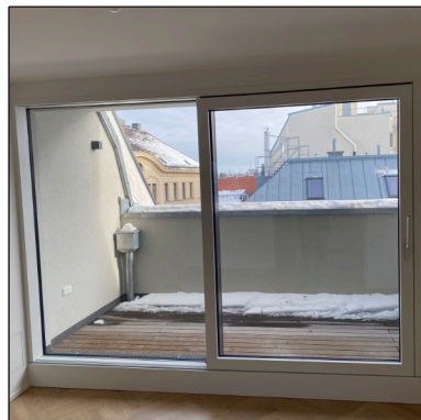
Vertikalfenster Katzbeck Holz Alu, 3 Scheiben Verglasung Holz innen: Fichte H011 verkehrsweiß matt Alu außen: pulverbeschichtet DB 703 Fenstergriff: Liege silber eloxiert
