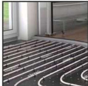
Fußbodenheizung
