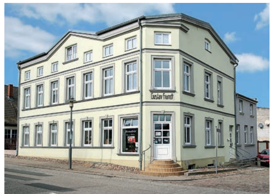
24 - Wohn - und Geschäftshaus auf Rügen
