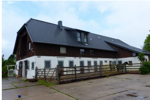
Bild 2: Wohn- und Wirtschaftsgebäude 4 Wohnungen 300 m 2 WF im DG 11 Pferdeboxen, 340 NF im EG
