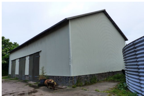
Bild 6: Maschinenhalle rd. 230 m 2 NF
