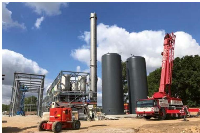
*Größtes mobiles Waldhackschnitzel-Heizkraftwerk der Welt mit 3.900 kW Feuerung und 450 kW-Heißdampf-Turbine im Bauzustand. Inbetriebnahme: Q1/2021.*
