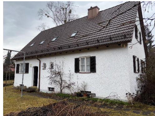
Süd- und Westfassade
