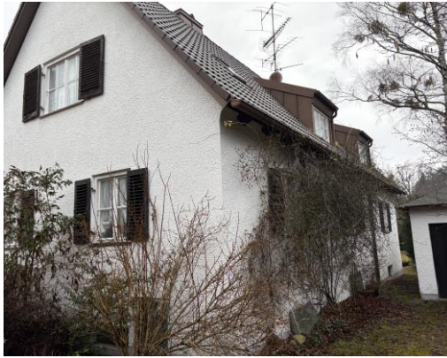
Süd- und Ostfassade
