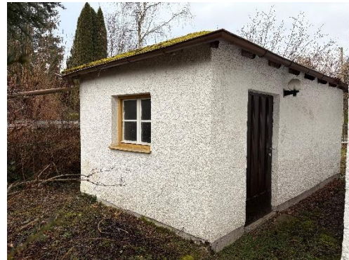
Nord- und Westfassade Garage
