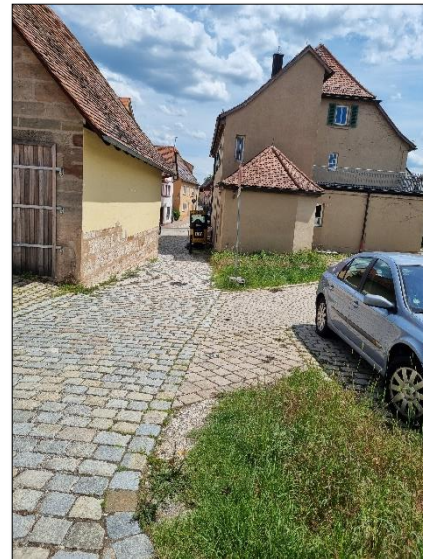
Blick entlang der nordöstlichen Grundstücksgrenze
