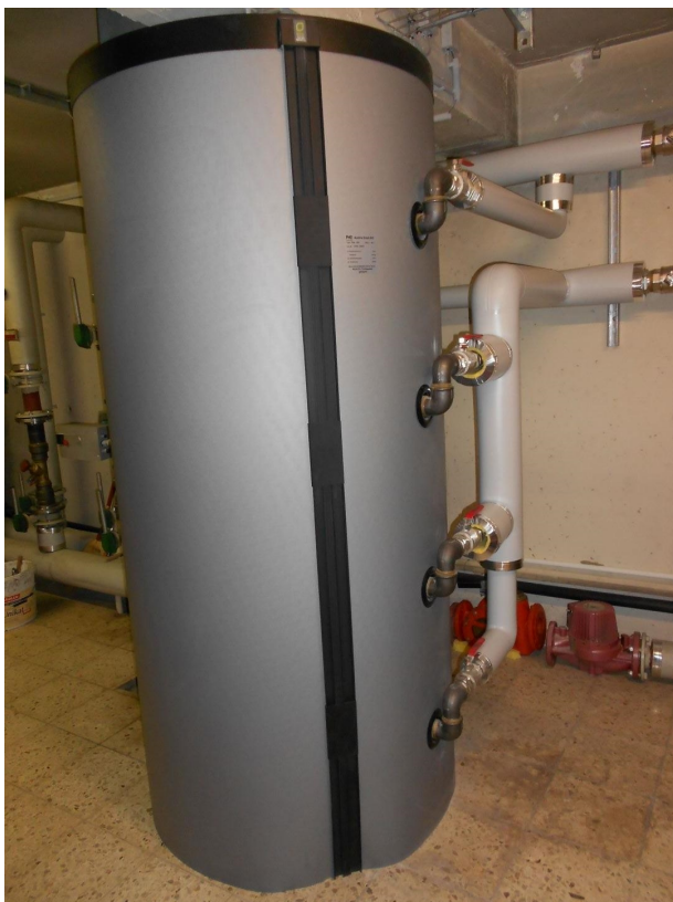
EAW Salzburgerstrasse 46 - Bestandsbesichtigung 05.jpg
