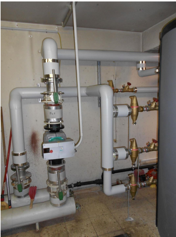
EAW Salzburgerstrasse 46 - Bestandsbesichtigung 07.jpg
