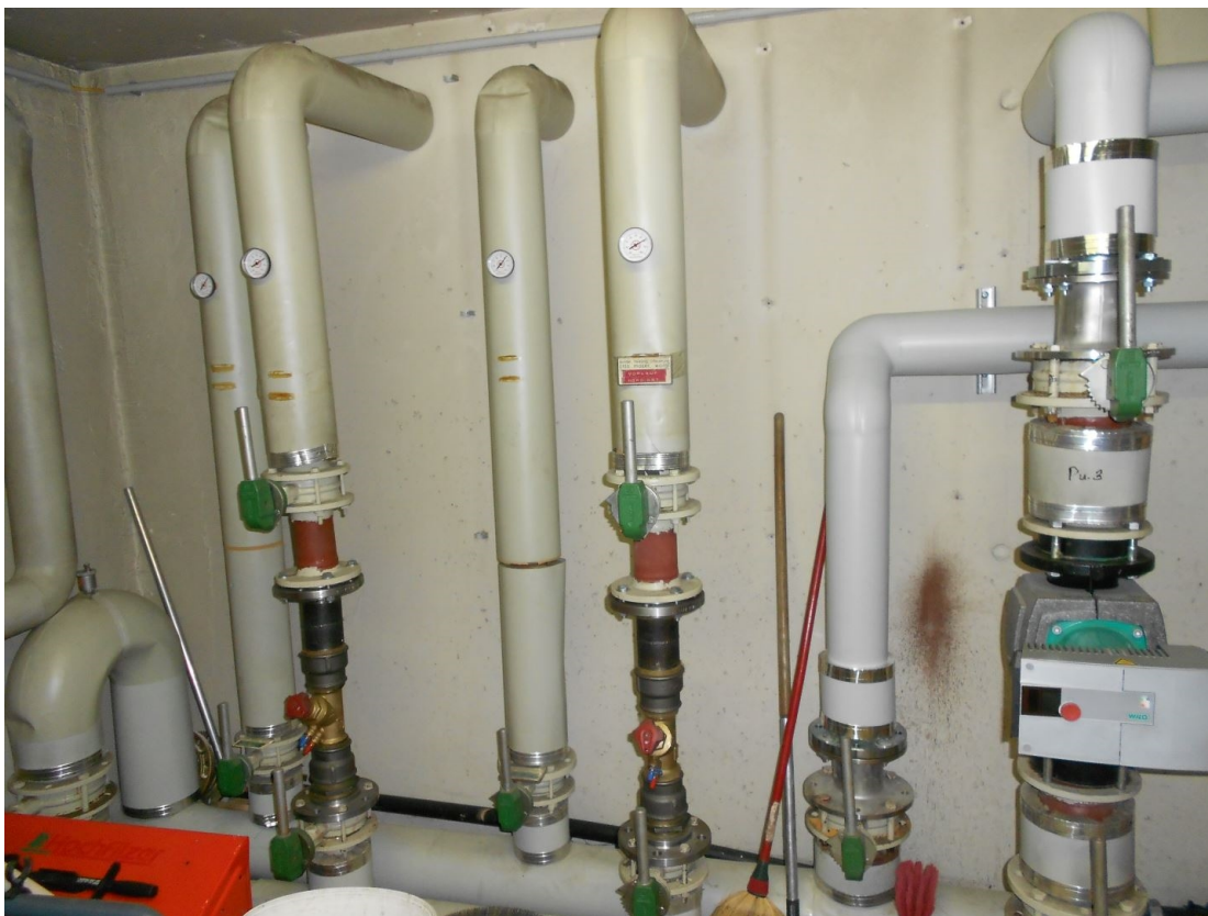
EAW Salzburgerstrasse 46 - Bestandsbesichtigung 08.jpg
