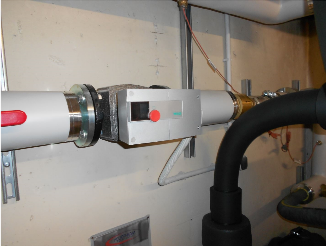
EAW Salzburgerstrasse 46 - Bestandsbesichtigung 06.jpg
