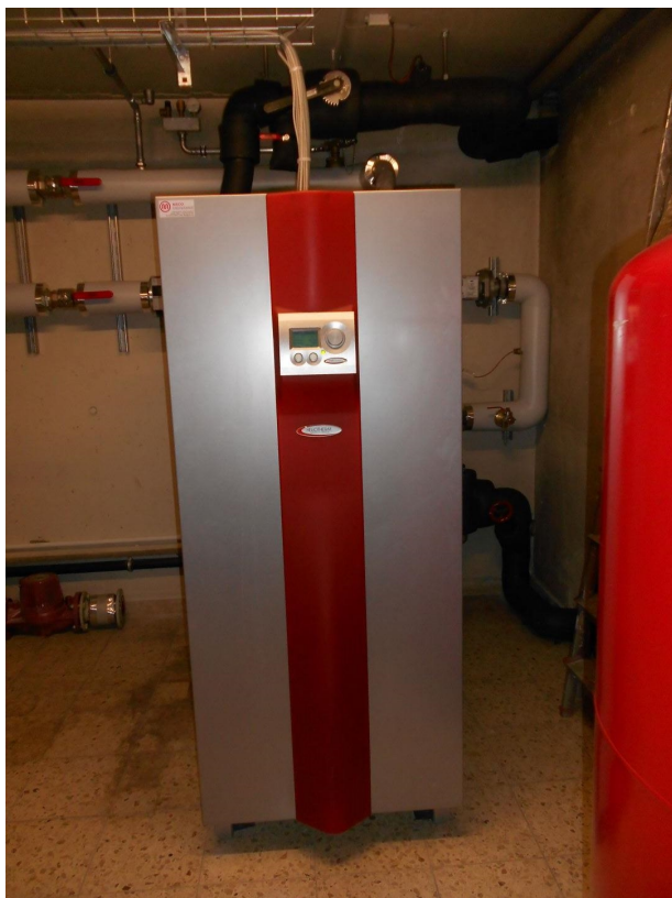
EAW Salzburgerstrasse 46 - Bestandsbesichtigung 03.jpg
