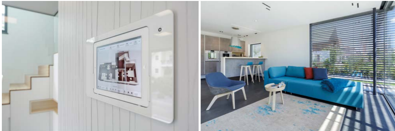
Smart Home System für mehr Komfort und Effizienz, z.B. automatische Verschattung
