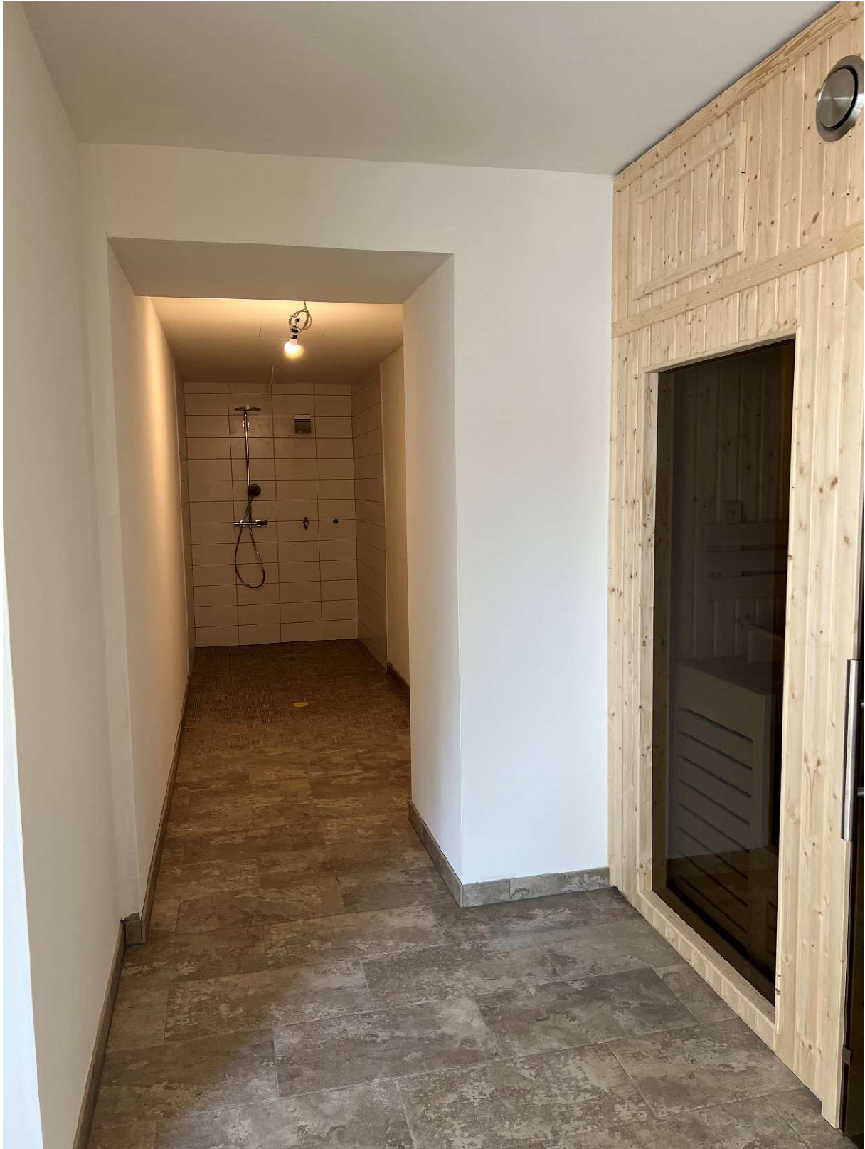
Dusche für die Sauna mit Schwallbrause und Kneippschlauch
