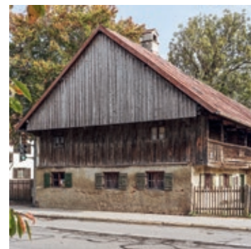
Vor der Renovierung
