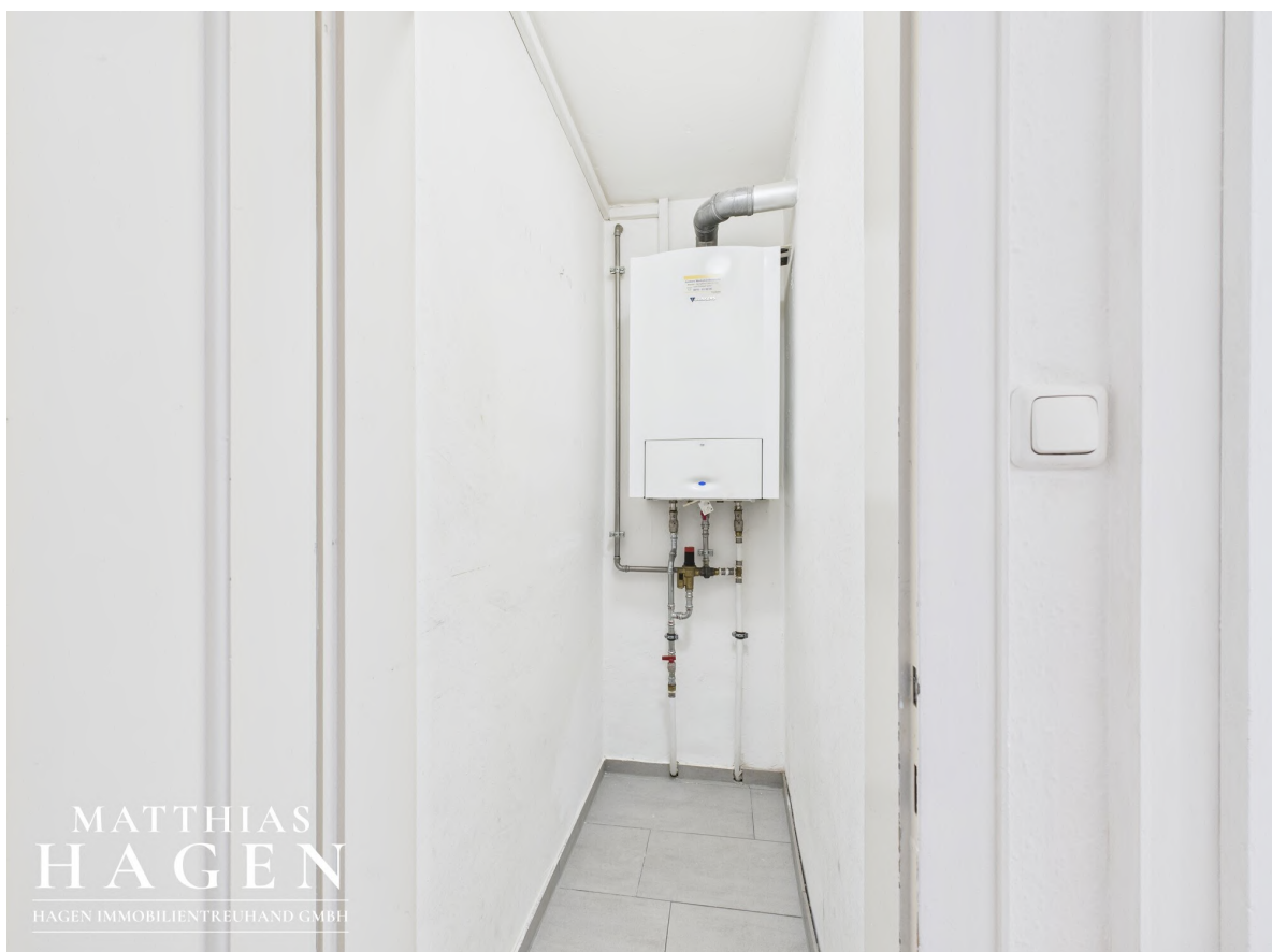
Abstell- und Heizraum
