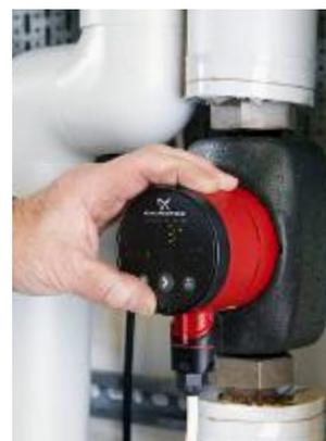
Eine Hocheffizienzpumpe schickt das erwärmte Heizwasser vom Kessel zum Speicher beziehungsweise zu den Heizkörpern und das abgekühlte Wasser zurück zum Kessel. Das spart effektiv Strom
