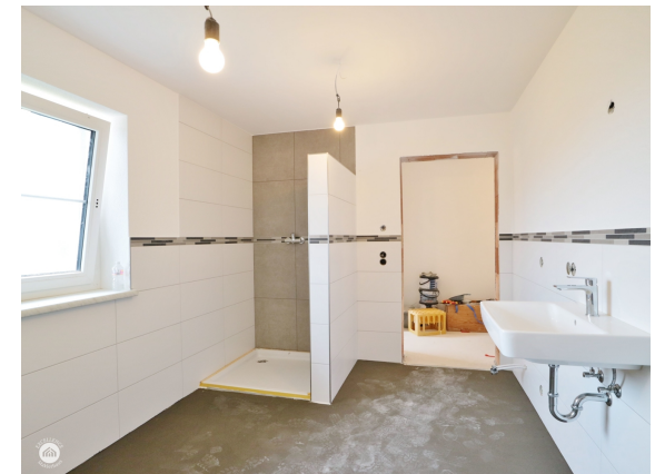
Bad mit Dusche
