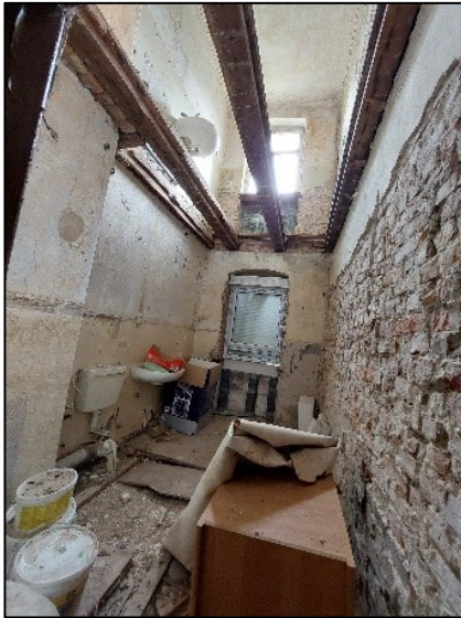
Badezimmer EG / 1.OG
