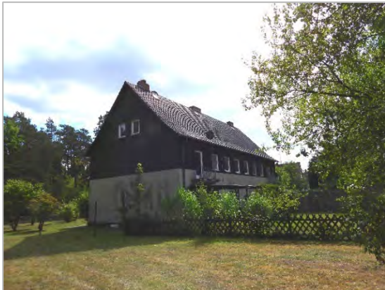
seitliche Ansicht aus Süd-Ost Haus Nr. 4
