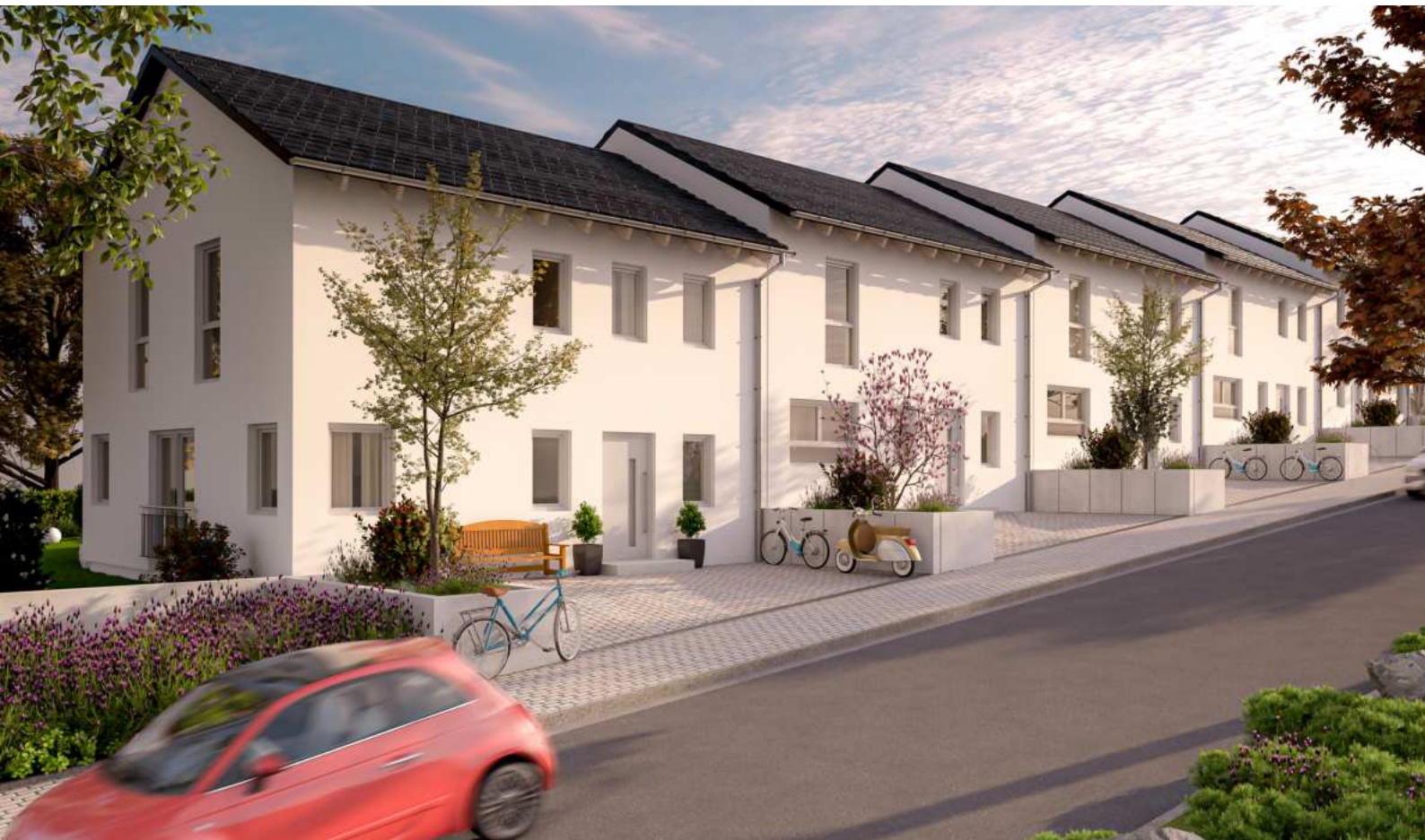
▼ Ansicht der Reihenhäuser von Nordosten
