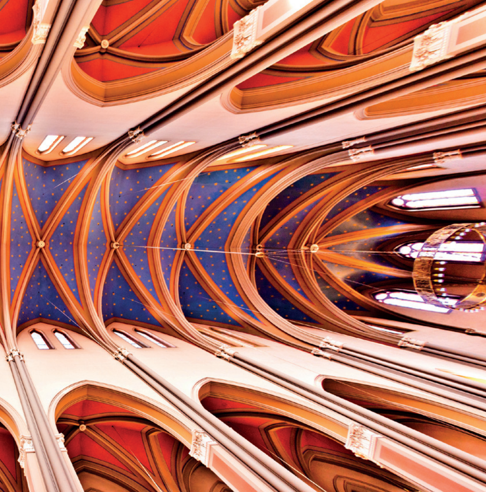
Innenansicht der Marktkirche
