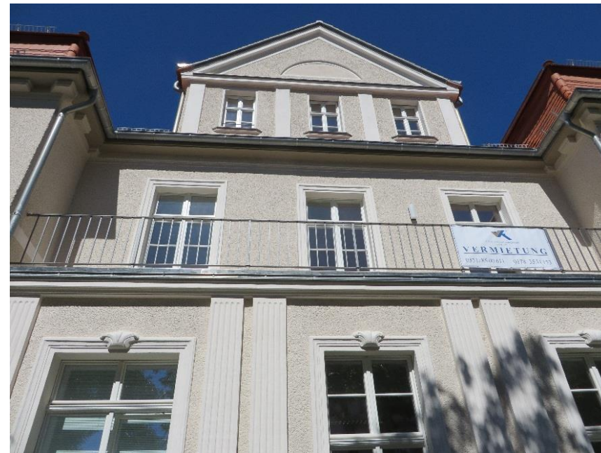
Denkmalgerechte Fassadenrekonstruktion V.V.K.-Objekt Pillnitzer Landstr. 30
