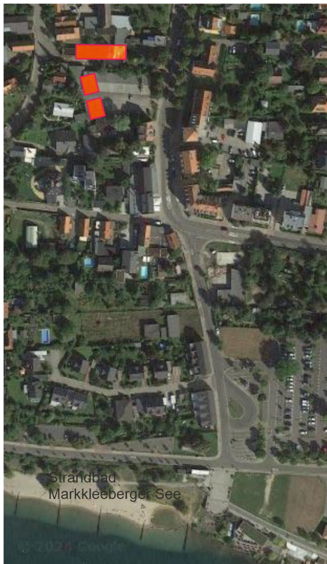
Abb. 2 Luftbild mit Markierung Baugrundstück
