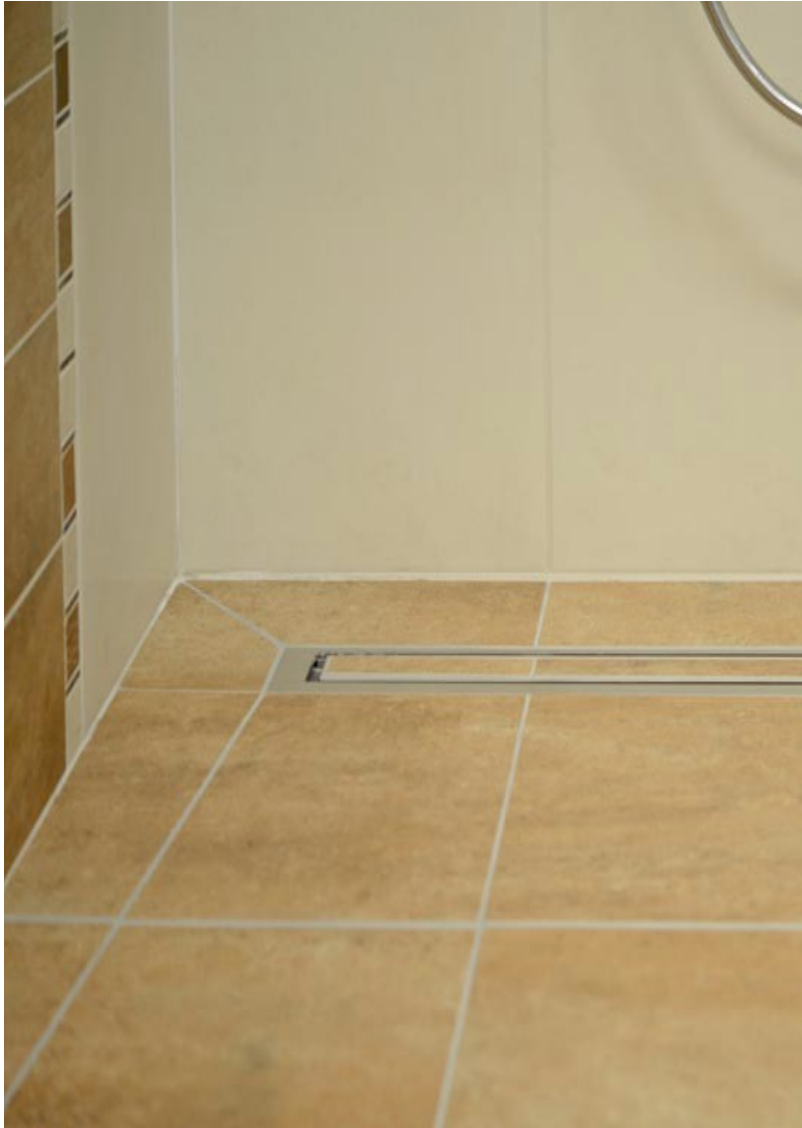
Abb. 13 Beispiel für bodengleiche Ausführung Dusche mit Entwässerungsrinne
