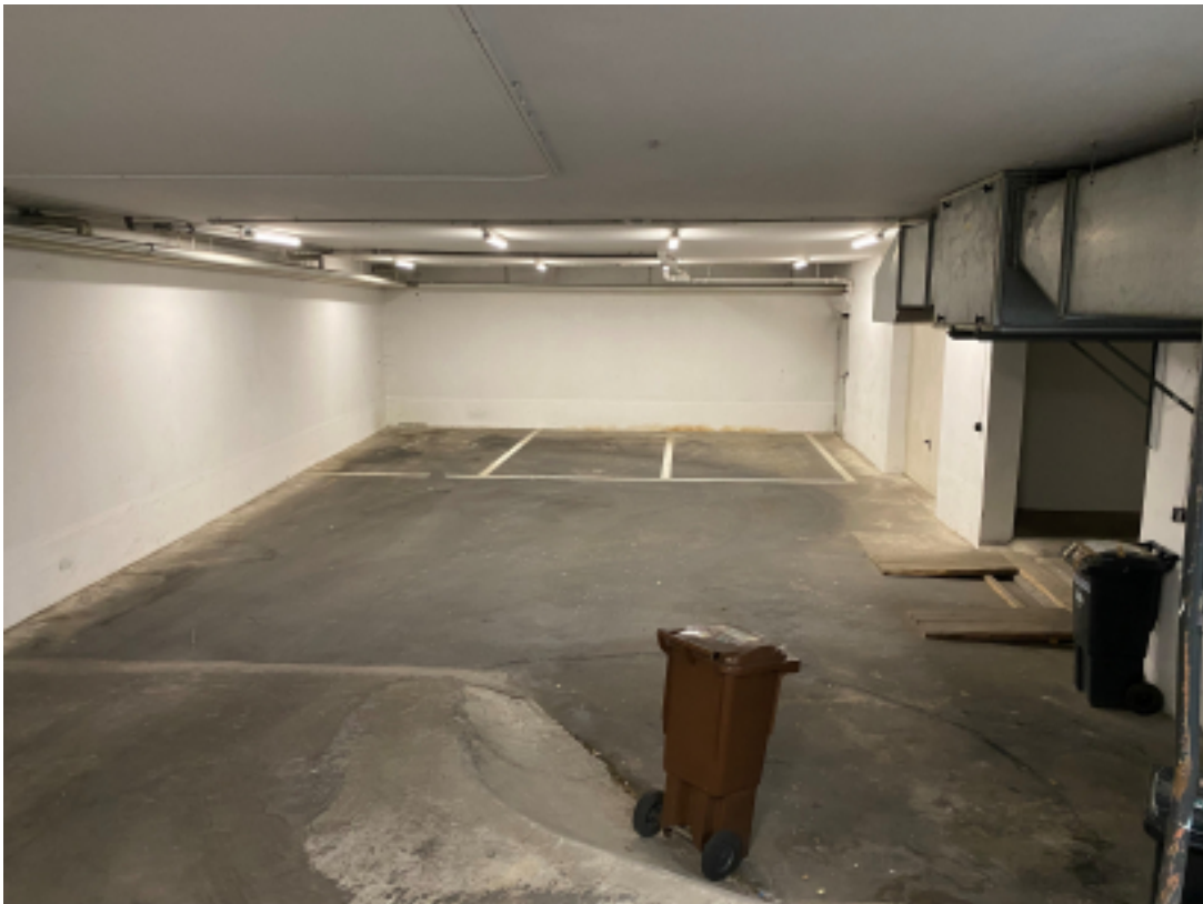
Bild oben: Zufahrt Tiefgarage Bild unten: Tiefgarage
